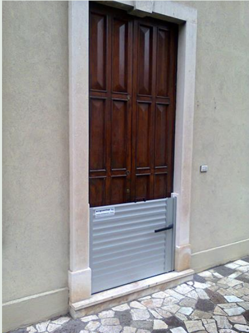
Flutschott manuell, Quelle: O. Koch
