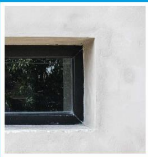
▲ Kalkzementputz auf oberem Teil der Außenwand
