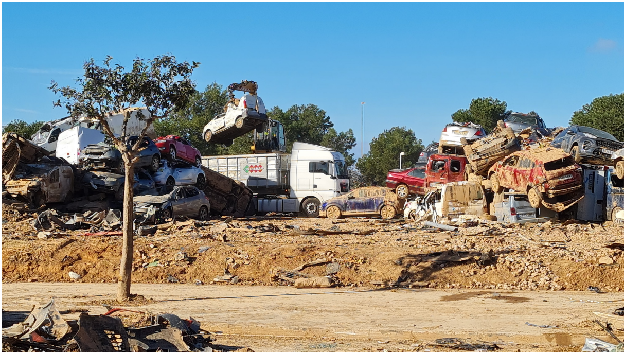
Fig. 3 Carga de coches con brazo de agarre, sin bombeo de sustancias peligrosas y sin extracción de baterías (Stephan Müllers)
