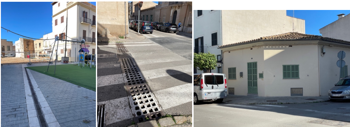
Abbildung 24. Beispiele für Straßenentwässerung an der Placa de la Quartera (links) und entlang der Carrer d'en Ramon Lull Beato (Fotos: Fekete, Inca, 26 Feb. 2025).
