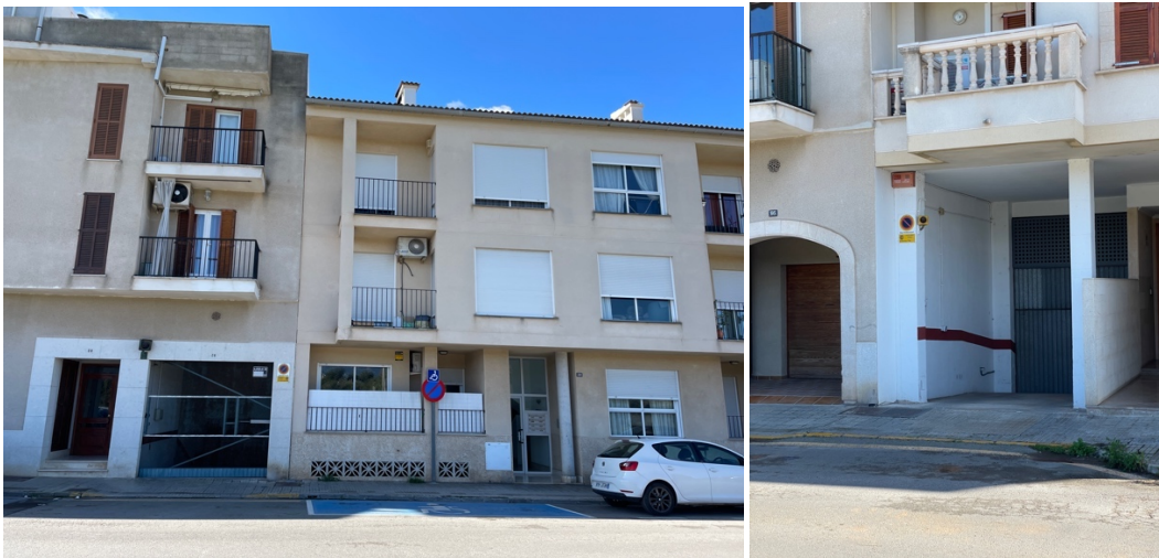
Figura 27. Ventanas de sótano y entradas de garaje subterráneo a lo largo de la vía urbana de borde Carrer de Mandrava (Fotos: Fekete, Inca, 26 feb. 2025).
