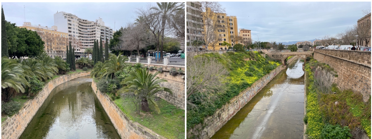
Abbildung 8. Umgeleiteter Kanal des Flusses Sa Riera mit Betonbett und -wänden in Palma (Fotos: Fekete, Palma, 25 Feb. 2025).
