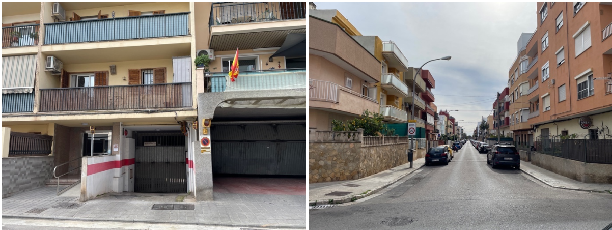
Abbildung 5. Tiefgarageneinfahrten im Wohngebiet unter Wohnblöcken und Lage des Wohngebiets (Fotos: Fekete, Palma, 25. Feb. 2025).
