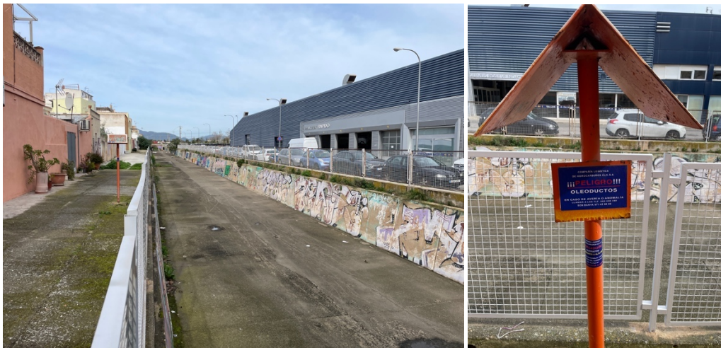
Figura 3. Canal fluvial del torrent den Barberà cruzando la Ma-13A, con lecho y muros de hormigón, junto a un vendedor de coches, y una señal de advertencia de nivel del río y productos petrolíferos expuestos en una crecida, vista hacia el norte (Fotos: Fekete, Palma, 25 Feb. 2025).
