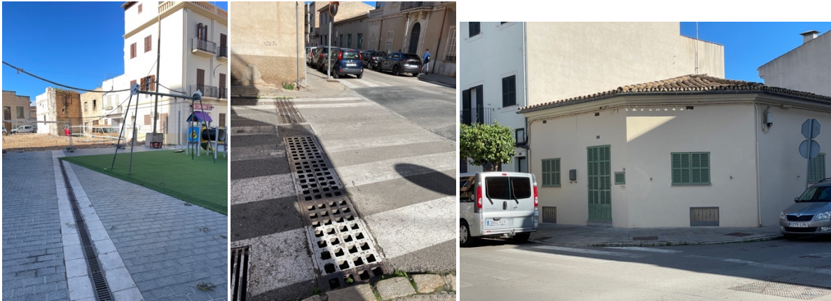
Figura 24. Ejemplos de drenaje de calles en la Placa de sa Quartera (izquierda), y a lo largo del Carrer den Ramon Llull (Fotos: Fekete, Inca, 26 feb. 2025).
