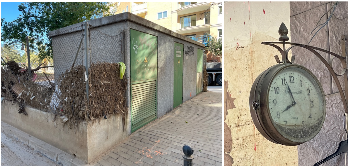
Abb. 10 Hochwassertriebputz am Zaun neben Infrastruktur für Elektrizität, stehengebliebene Uhr in einem geschädigten Café (Fekete, 9.1.2025)
