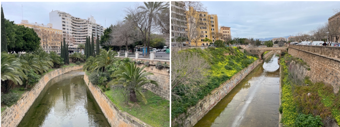
Figura 8. Canal desviado del río Sa Riera con lecho y muros de hormigón en Palma (Fotos: Fekete, Palma, 25 feb. 2025).
