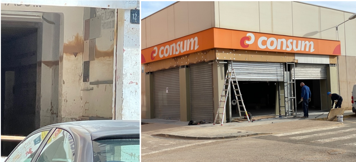
Abb. 3 Hochwasserstand an einer Garagenwand und Renovierungsarbeiten an einem Supermarkt in Paiporta (Fekete, 8.1.2025)
