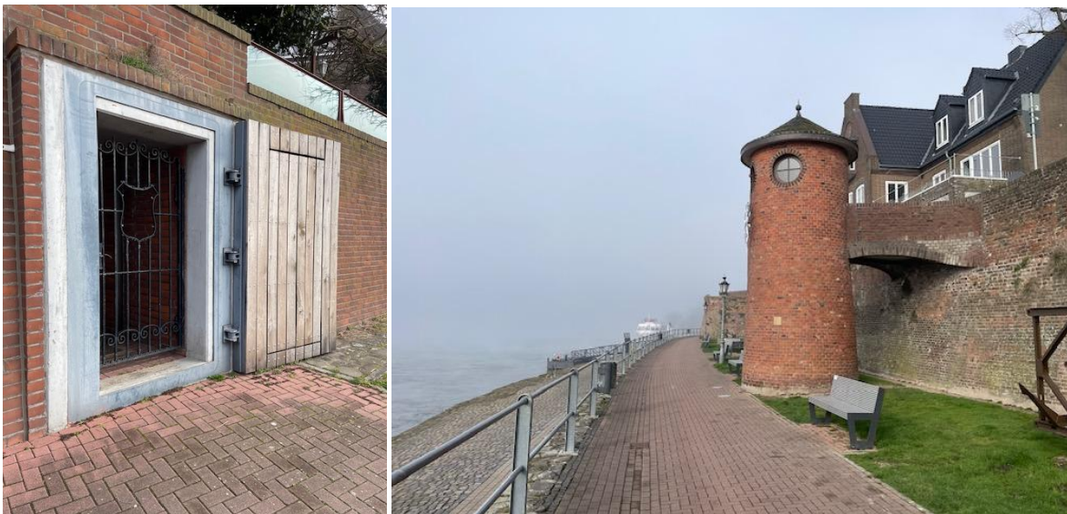
Abbildung 4: Hochwasserschutzmauer und Pegelturm in Rees am Rhein, Deutschland (Fotos: Fekete, 14.3.2025)
