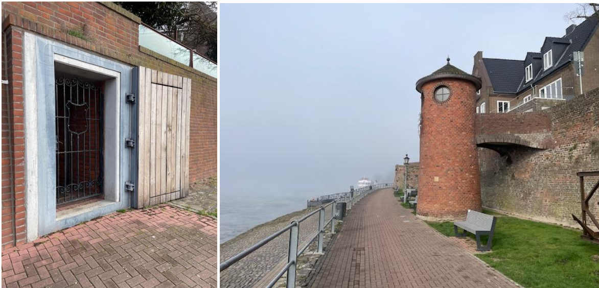
Figura 4: Muro de protección contra inundaciones y torre de medición en Rees am Rhein, Alemania (Fotos: Fekete, 14.3.2025)
