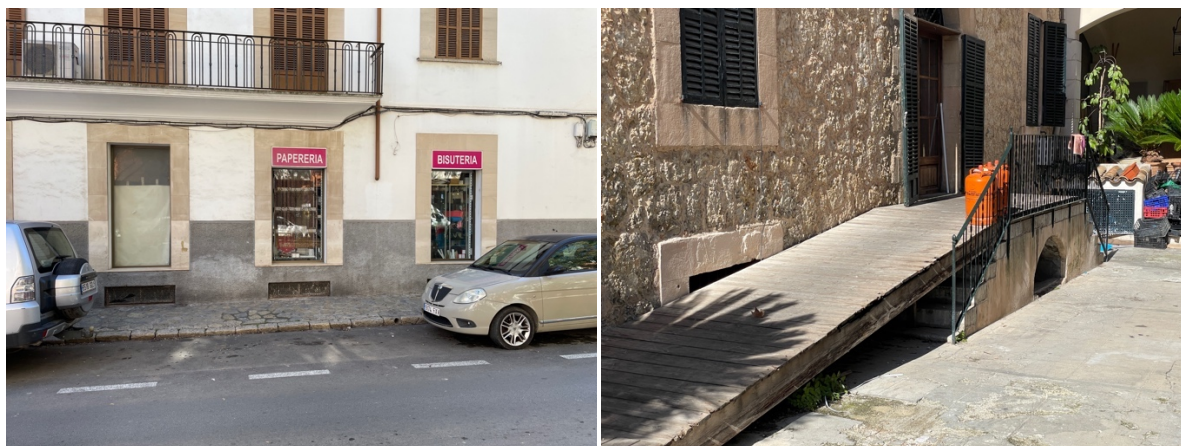
Figura 21. Se observan ventanas de sótano ocasionalmente a lo largo de la Gran Vía Colom (Fotos: Fekete, Inca, 26 feb. 2025).
