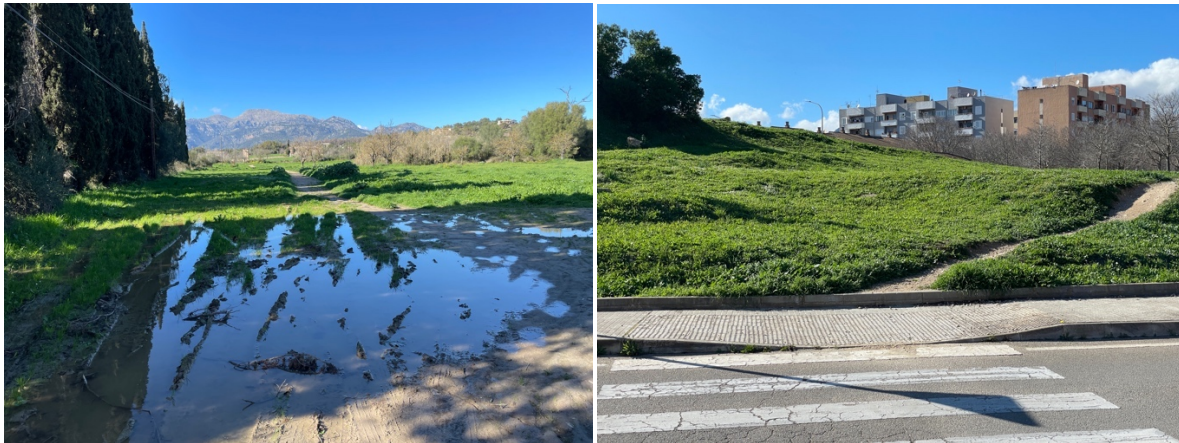
Abbildung 28. Stehendes Wasser nach Regen an der Carretera de Mancor de la Vall und in der nahe gelegenen Wohnsiedlung (Fotos: Fekete, Inca, 26 Feb. 2025).
